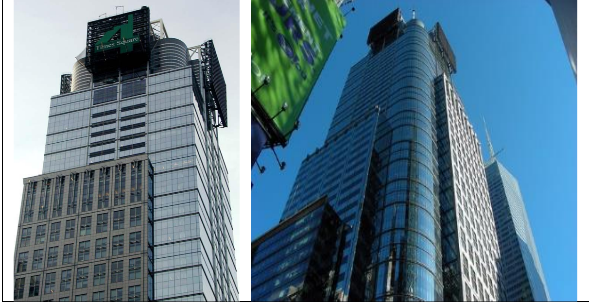
شكل (8.3): لوحات Photovoltaic Panels من الخارج. المصدر: (السواط، 2005 م).
