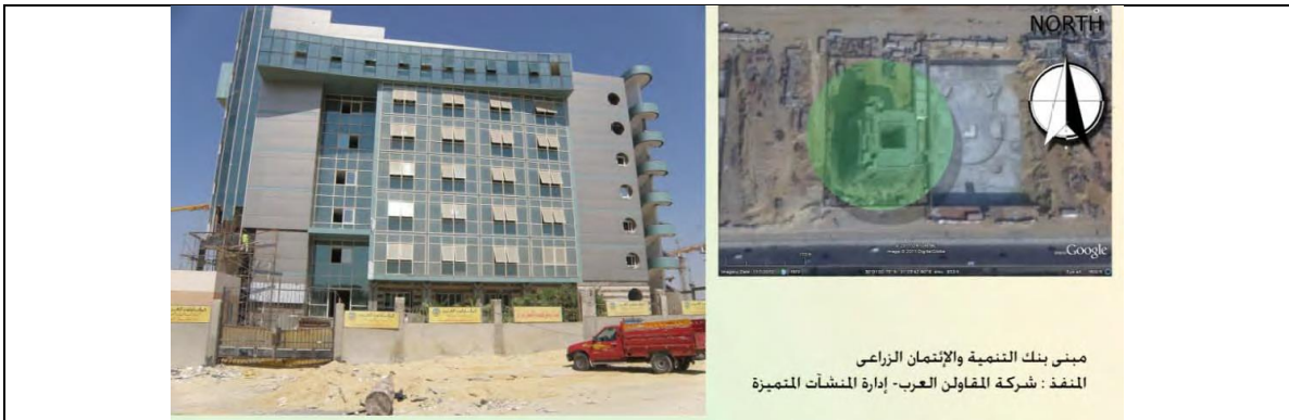
شكل يوضح: مبنى بنك التنمية والائتمان الزراعي - توجيه الواجهة الزجاجية ناحية الجنوب - تكسيات الواجهة من الأليكووند (الواح الالمنيوم المزدوجة) مع وجود فناء داخلي غير مزروع. المصدر: الباحث وخرائط جوجل.
