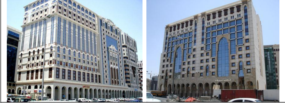
شكل (27.4): التكرار والتوأمة في الواجهات عن اليمين، والتجانس عن اليسار بحيث يتم استخدام نفس أنواع وألوان مواد كسوات الواجهات لمعالجة العلاقة بين المباني الملاصقة أو الملتصقة جزئياً. المصدر: (الحناوي، 2012م).
