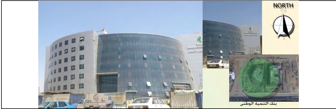
شكل يوضح: مبنى البنك الوطني للتنمية - توجيه الواجهة الزجاجية ناحية الجنوب تكسيات الواجهة من الأليكووند (الواح الالمنيوم المزدوجة).. المصدر: الباحث وخرائط جوجل.
